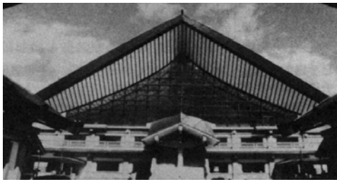
• Iwate Prefectural Budoh-kan
